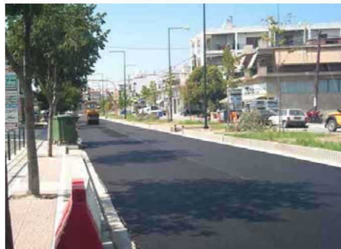
Συμπίσση της τροποποιημένης με ελαστικό ασφάλτου στην οδό Βασιλικών στη Λαμία
