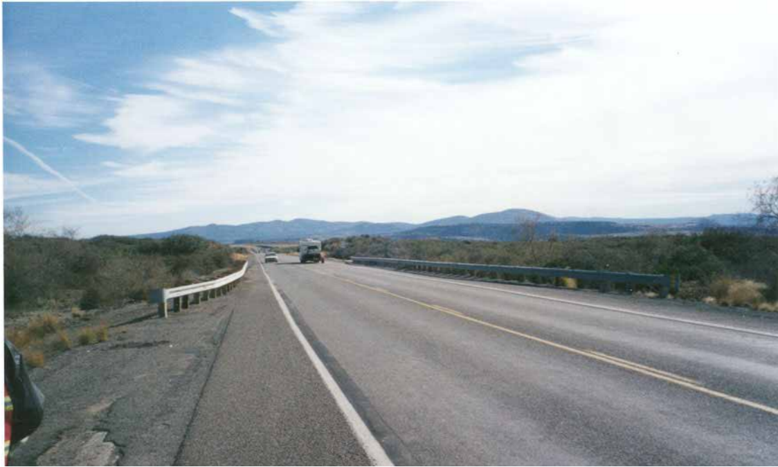
22 χρόνια εξαιρετικής απόδοσης οδοστρώματος με τροποποιημένη με ελαστικό άσφαλτο. Έργο στο Dewey.
