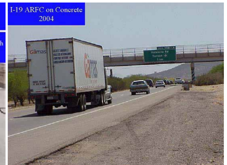
Interstate 19. Δεκαέξι χρόνια μετά την επικάλυψη της ασφάλτου
