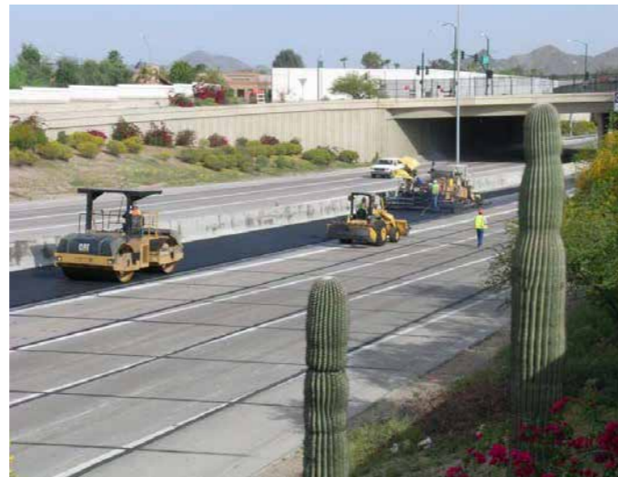
Κατασκευή της τροποποιημένης με ελαστικό ασφάλτου
