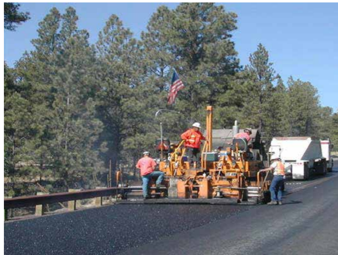
Κατασκευή της τροποποιημένης με ελαστικό ασφάλτου
