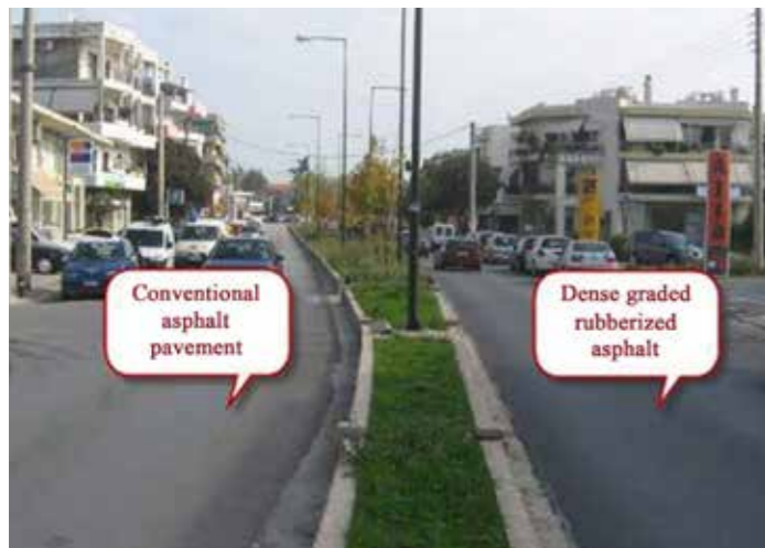
Πιλοτικό έργο στην οδό Βασιλικών στη Λαμία. Αριστερά η συμβατική ασφαλτος και δεξιά η τροποποιημένη με ελαστικό ασφάλτος
