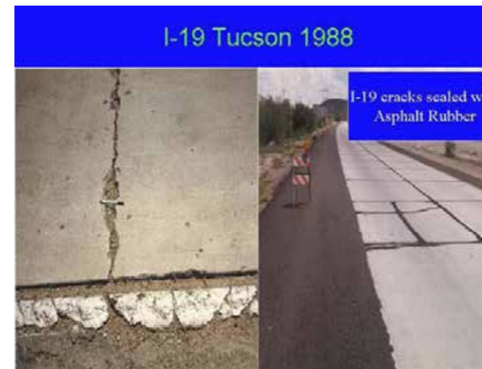
Interstate 19. Πριν την επικάλυψη της ασφάλτου
