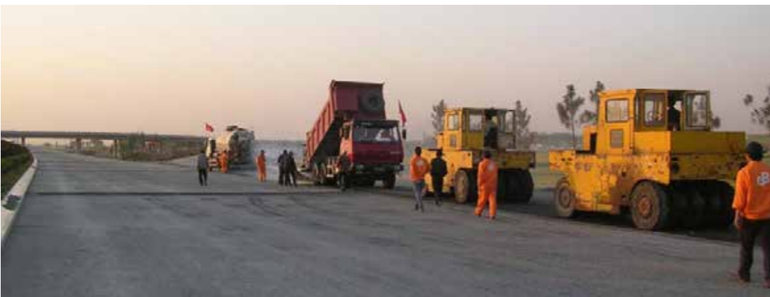
Εφαρμογή AR-SAMI πάνω σε βάση τσιμέντου στην Κίνα ως μέρος συστήματος πολλαπλών στρωμάτων AR.
